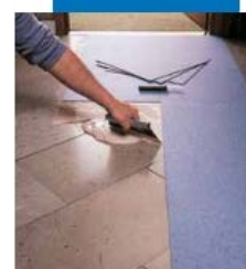
Collage de PVC sur support non absorbant avec Adesilex G19
