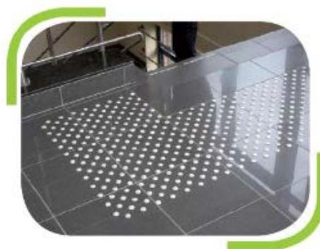
Le système VIADOT, en matériau composite est fixé au sol par un système breveté de combinaison d'adhésifs permettant une installation renforcée et durable.
