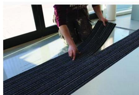
Ce nouveau concept, très innovant et très facile à installer en pose libre. Les lames sont adhésivées côté envers avec une colle hot-melt repositionnable (5-6 fois maxi), ce qui permet une pose parfaite bien alignée et des joints quasi-invisibles (sauf en cas de pose en quinconce).
